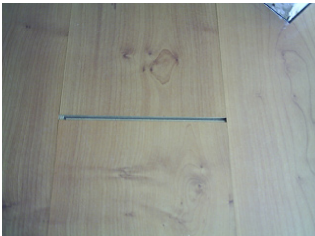
4 . Separación de tablas producto del uso, sin la debida precaución y sin la debida precaución y mantención.
