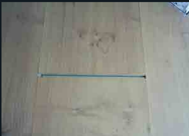
4. Separación de tablas producto del uso, sin la debida precaución y sin la debida precaución y manutención.
