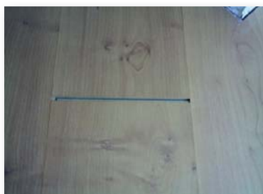
Fig. 4 Separación de tablas producto del uso, sin la debida precaución y mantención
