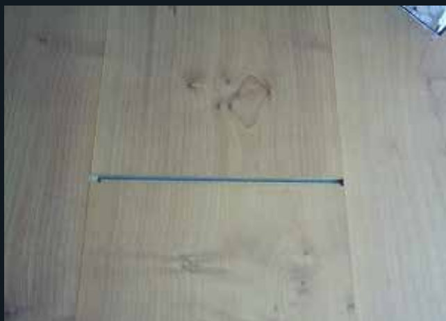
4. Separación de tablas producto del uso, sin la debida precaución y sin la debida precaución y mantención.
